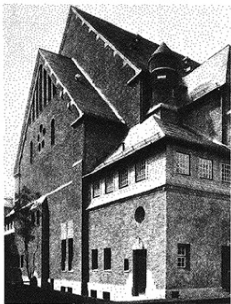
21. Synagoge Friedberger Anlage, 1907. Ostseite
